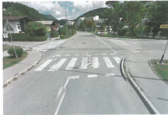
Slika 5: Prehod za pešce v okolici šole, ki ni dovolj varen in ne omogoča prehoda na vseh krakih ceste
